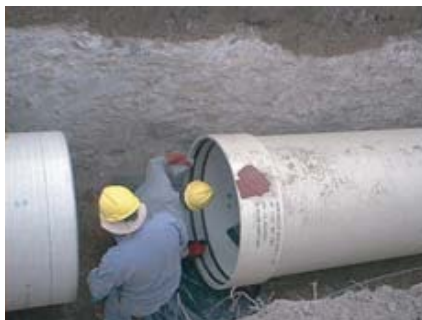
Ensamblado de tuberías
