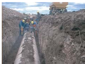
Relleno y compactación en la zona del tubo.
