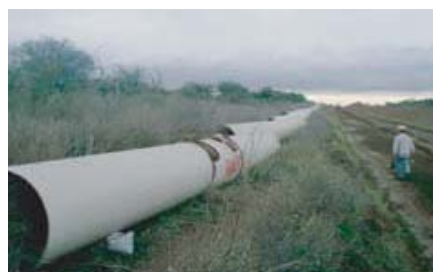
Desfilado de tuberías a pie de zanja.
