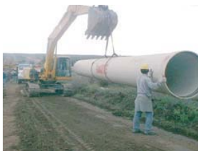
Movimiento de tuberías en obra.
