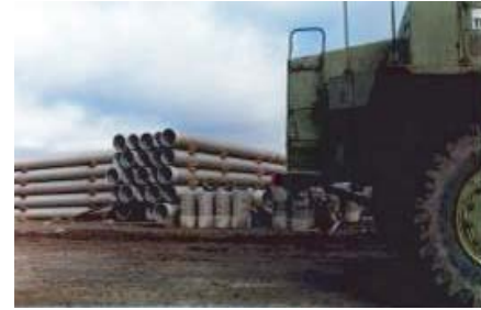
Tuberías almacenadas en obra.
