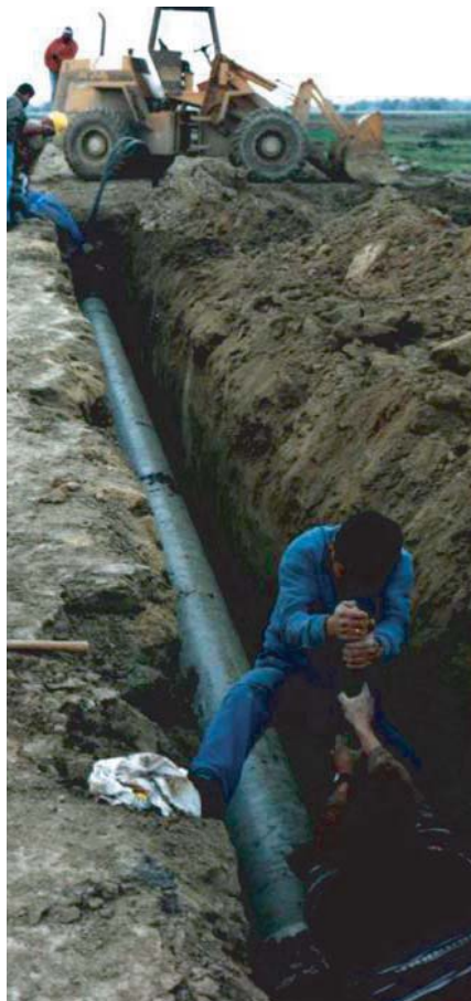
Enchufado manual de la tubería.
