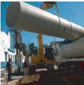
Bajada a Zanja de tubería DN 1200 con retroexcavadora en La Matanza.
