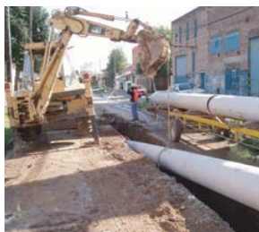
Refuerzo Escalada. Bajada a zanja DN 400 y 500 mm.
