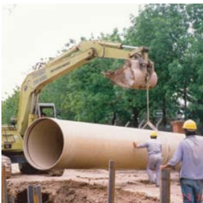
Colector Planta de Tratamiento Norte San Fernando, Bajada a zanja DN 800.
