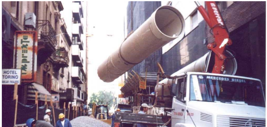
Transporte a Obra DN 1000 mm, Pluvio Cloacales de Radio Antiguo en Capital Federal.
