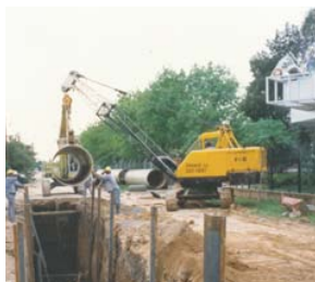
Bajada a zanja DN 500 mm, con retroexcavadora en Colector San Fernando
