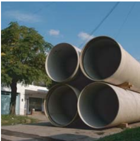
Colector Este Ramal Norte Avellaneda. Acopio a pie de zanja de tubería DN 1200
